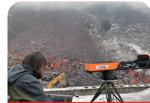
2024 YUNNAN ZHENXIONG LANDSLIDE
