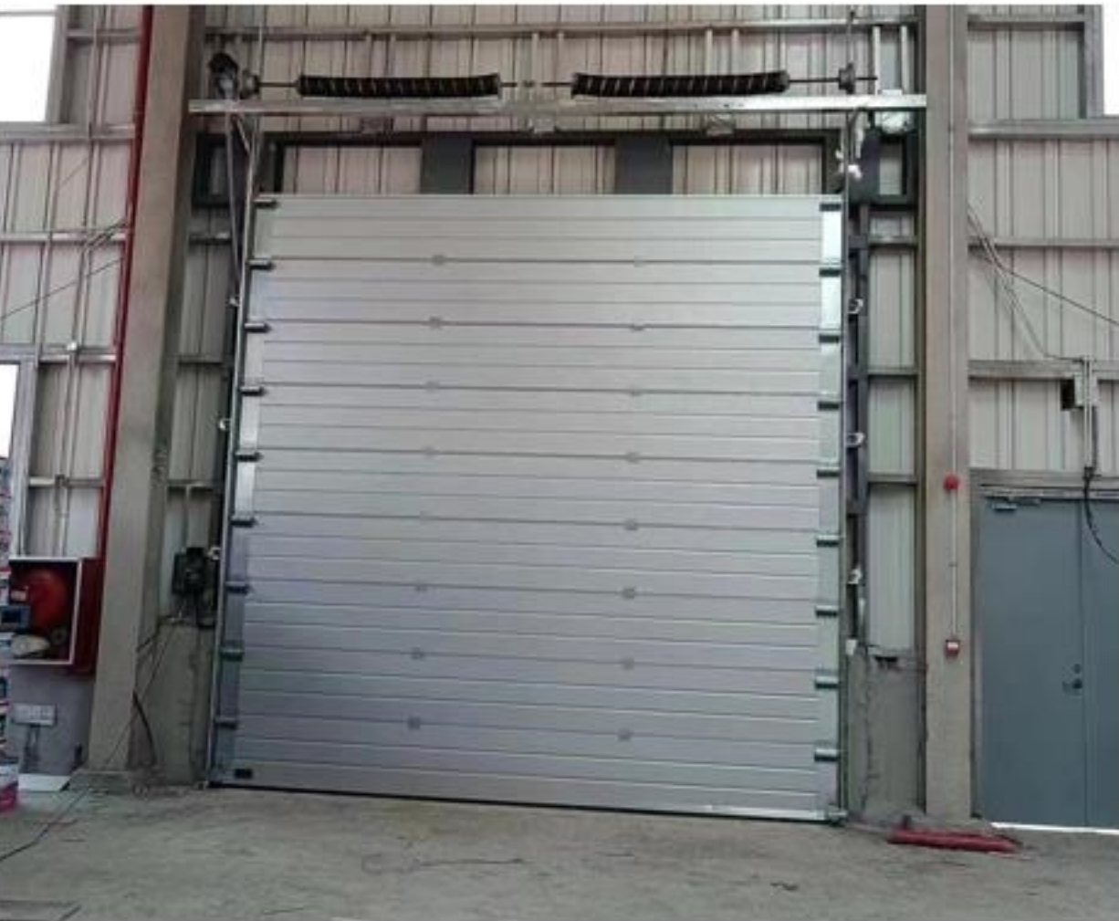
防坠落安全保护装置防止门体下坠伤害人和物 扭簧防断保护装置防止扭簧疲劳断裂 安全气囊防止门体向下运行时伤及人和物
