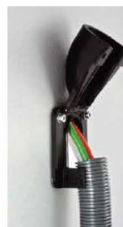
2. Insert conduit with cables
