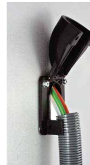
2. Insert conduit with cables
