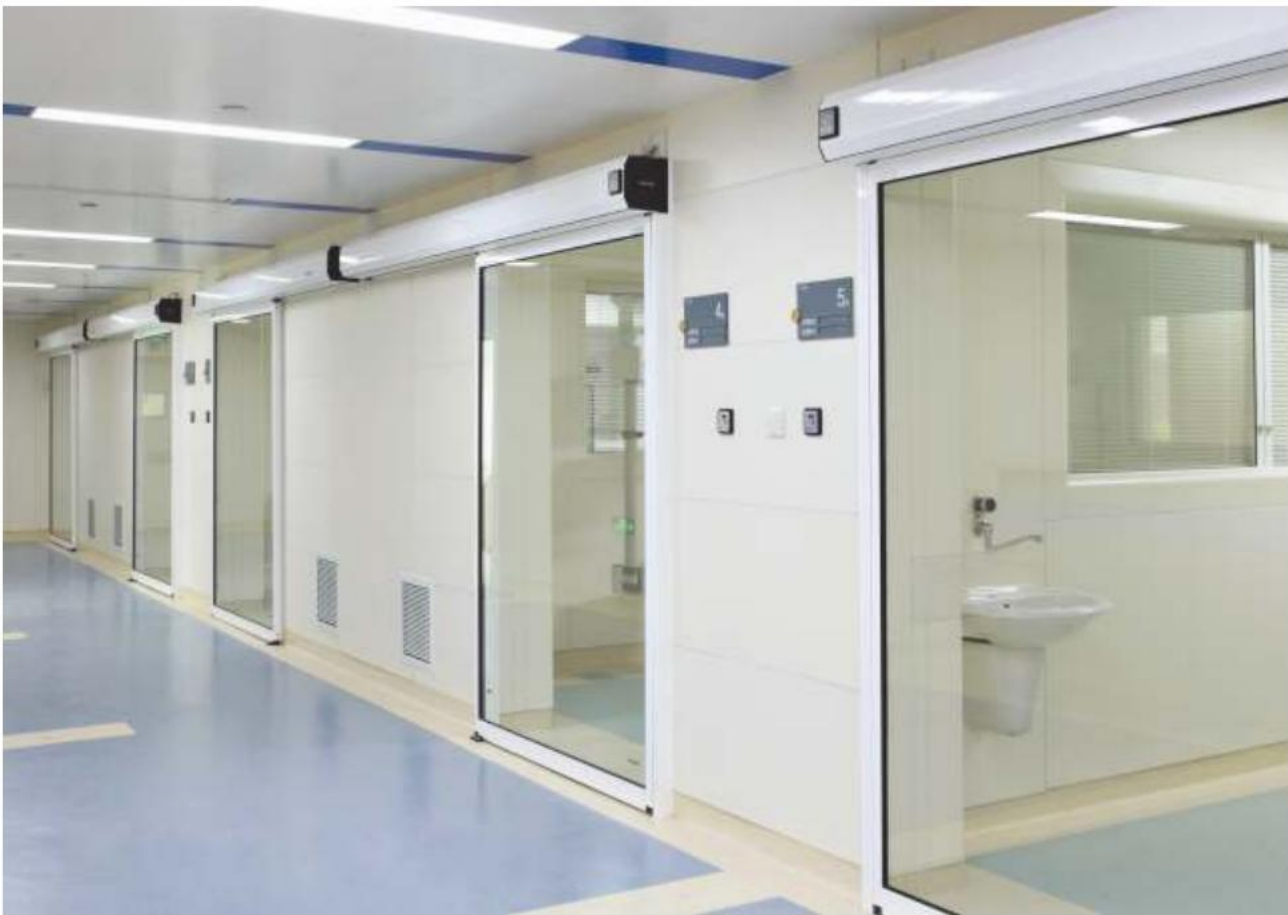
ICU double glass airtight door
